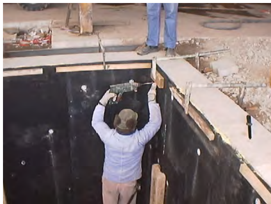
temporäre Sicherung mit Isolierstoffdübeln
