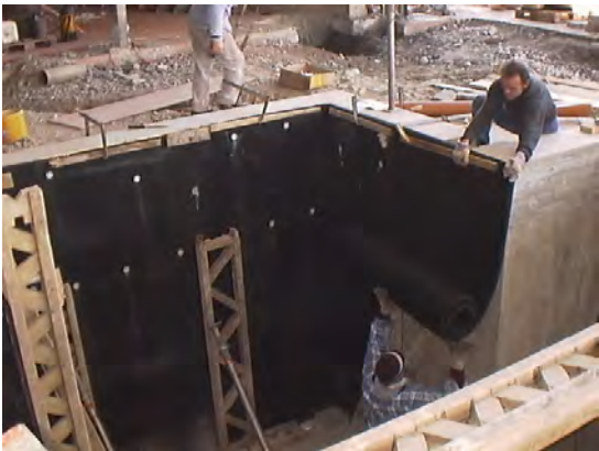
Verkleben der 2-fach Isoliermatten
